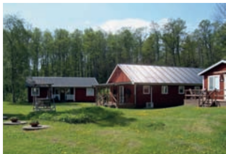
Vy från del av Lvbyn. Konferensbyggnaden i centrum.
