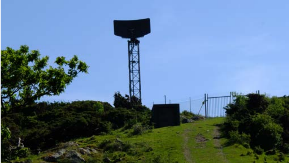
Befintlig radarstation Ps 870.
